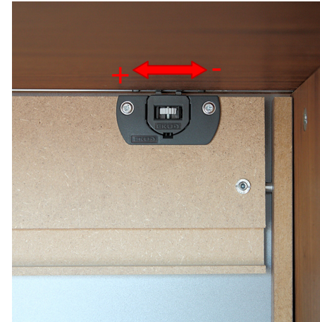
Abb.3 Höhenverstellung Schiebetür Vordfront
